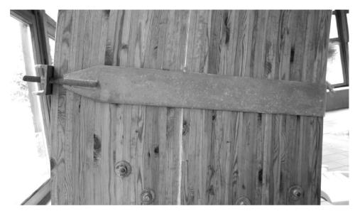
Fig. 1. Steel bandage element on the frame column in the pool at Hajdúszoboszló Rys. 1. Stalowa opaska na kolumnie szkieletu konstrukcji – basen w Hajdúszoboszló
